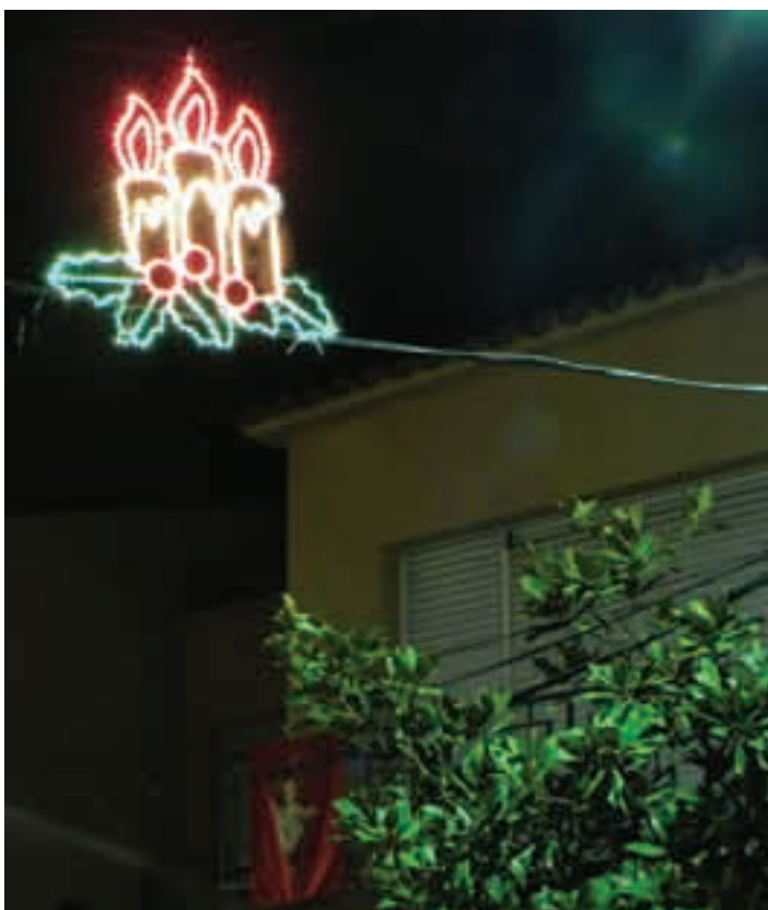
Montaje atirantado suspendido en una calle de ancho medio Muntatge atirantat suspès en un carrer d'amplada mitja Foto: prov. Lleida
