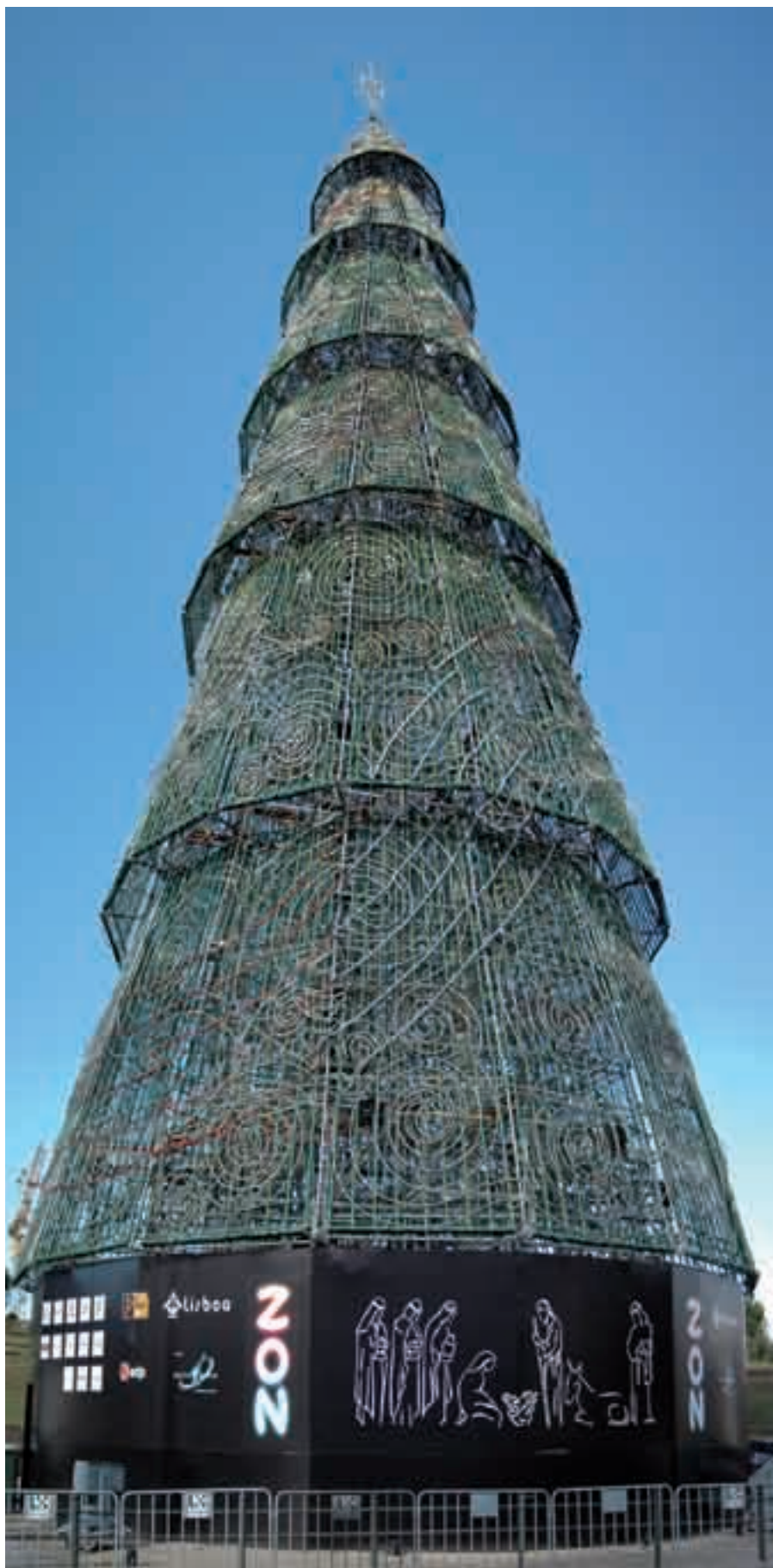
Estructura en forma de Arbol de Navidad iluminada para ser vista a gran distancia Estructura en forma d'arbre de nadal il·luminada per a ser vista a gran distància Foto Lisboa (Portugal)
