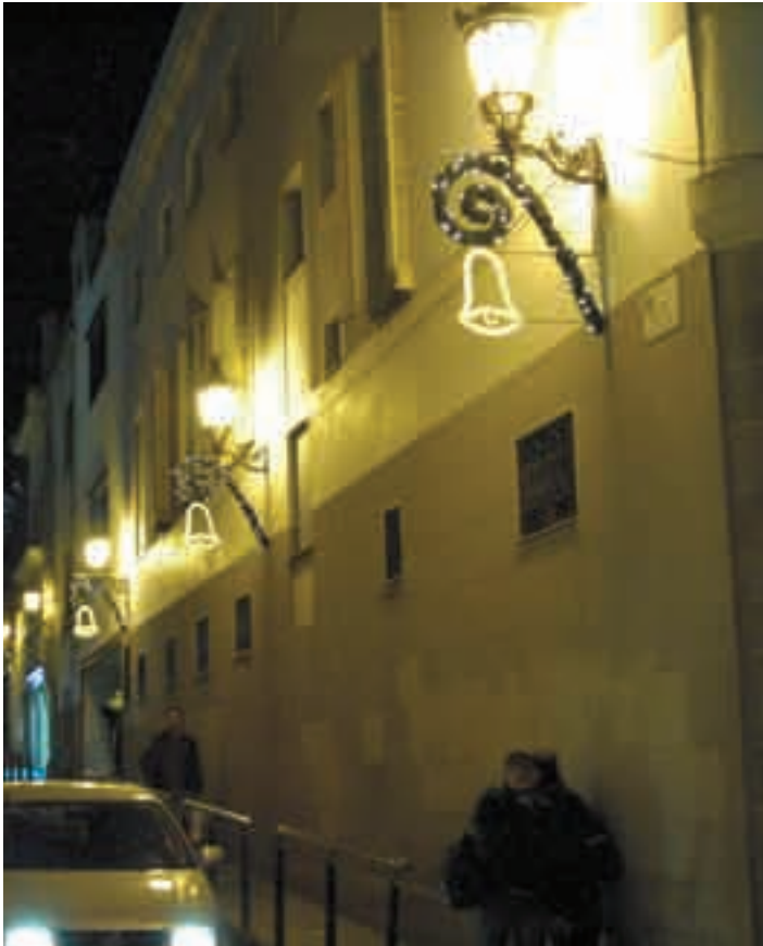
Montaje de rizo con campana directament a fachada Muntatge de rínxol amb campana directament a façana Foto: prov de Barcelona
