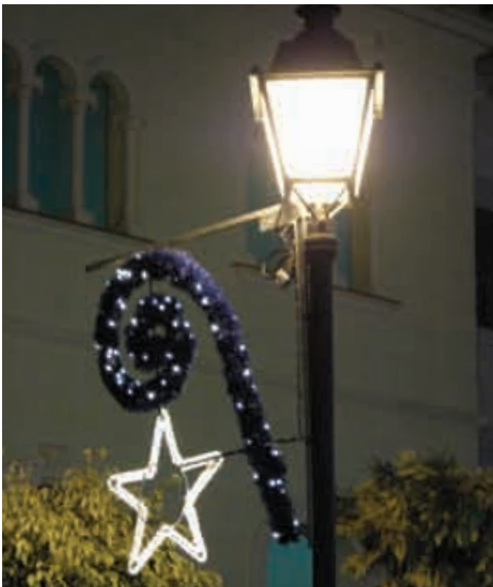
Montaje de un rizo con estrella directamente en una farola Muntatge d'un Rínxol amb estel directament en un Fanal Fografía: Prov de Madrid
