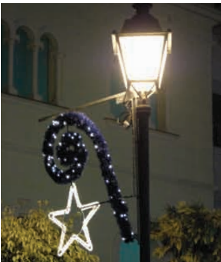
Montaje de un rizo con estrella directamente en una farola Muntatge d'un Rínxol amb estel directament en un Fanal Fografía: Prov de Madrid
