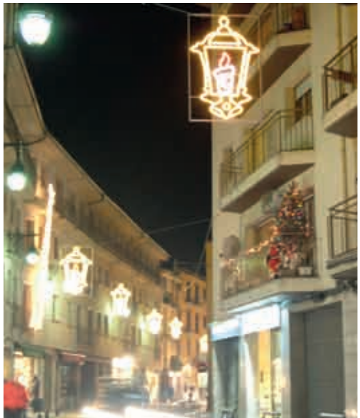
Montaje atirantado de faroles suspendidos en una calle de ancho medio Muntatge atirantat de fanals suspesos en un carrer d'amplada mitja Foto: Prov de Girona
