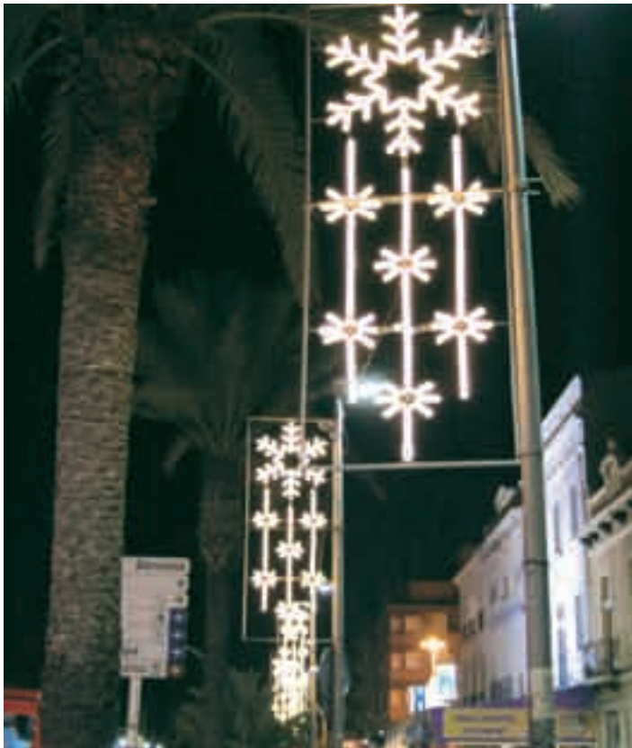
Figura instalada en farola con bridas metálicas en avenida amplia Figura Instal·lada a fanal amb brides metàl·liques d'una avinguda ampla. Foto: Prov. Barcelona
