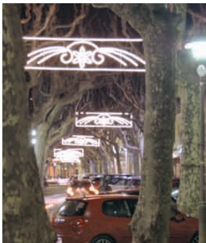
Montaje realizado con atirantado en el centro de una rambla Muntatge realitzat amb atirantat en el centre d'una rambla Foto: Prov Barcelona
