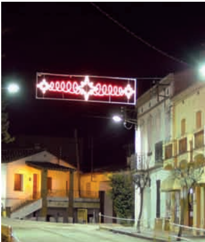
Montaje atirantado en el centro de carretera de ancho medio Muntatge atirantat en el centre d'una carretera d'amplada mitja Foto: Prov Barcelona
