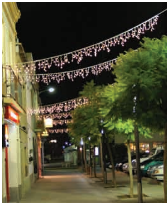
Montaje al aire suspendido (Foto: Prov. Barcelona) Muntatge l'aire suspès (Foto: Prov. Barcelona)
